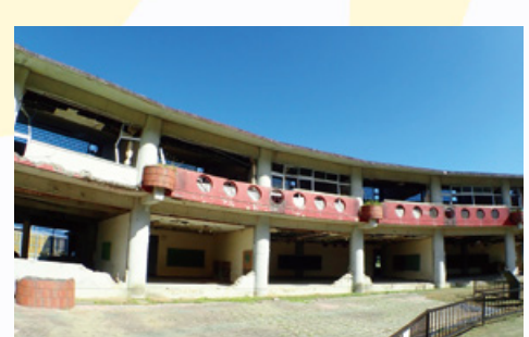
石巻市震災遺構大川小学校。多くの児童が犠牲になったその傷跡は深い
